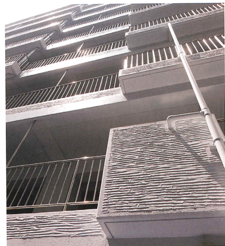
▲外壁面は平らではなく凹凸のある特殊な形状のため、施工には手間を要した
