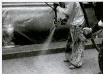
高剛性プラスチック吹付け
