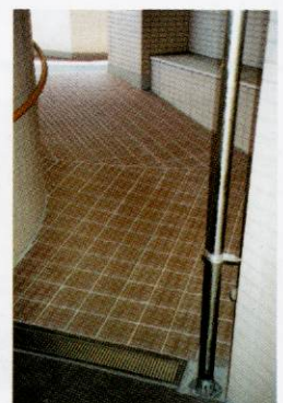
溝を作って流水を処理。手すりも新たに追加
