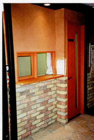
改修後 管理室外側
