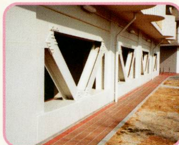
築28年目:耐震補強で耐久性アップ!
