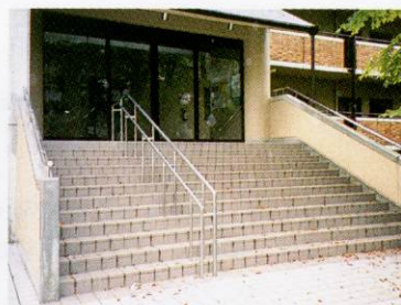
勾配をゆるやかに改善するとともに、高さの違う2つの手すりを設置
