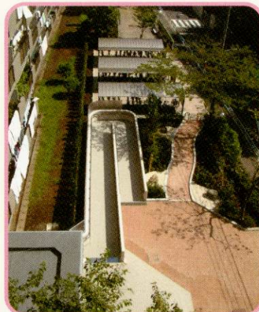
築23年目:スロープを取り付けて バリアフリーに
