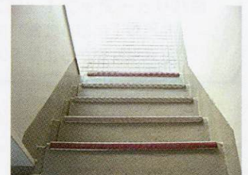
階段の最初と最後に赤いノンスリップを入れてわかりやすくした
