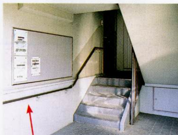
長めに手すりを設置
