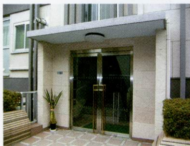
植込みや照明器具も一新し大きくイメージチェンジ
