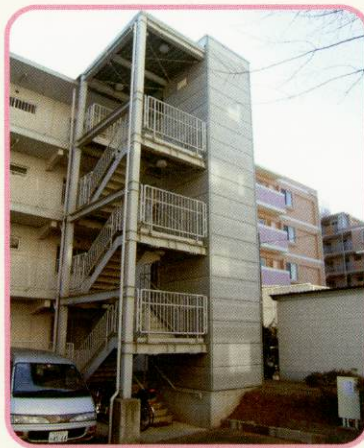
築25年目:エレベーターを新設して バリアフリーに
