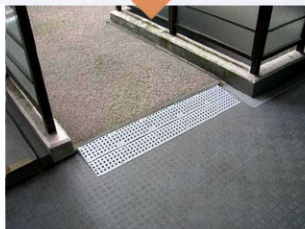
スロープ (ブロック)
