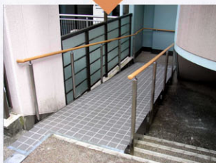
スロープ (鉄骨下地)
